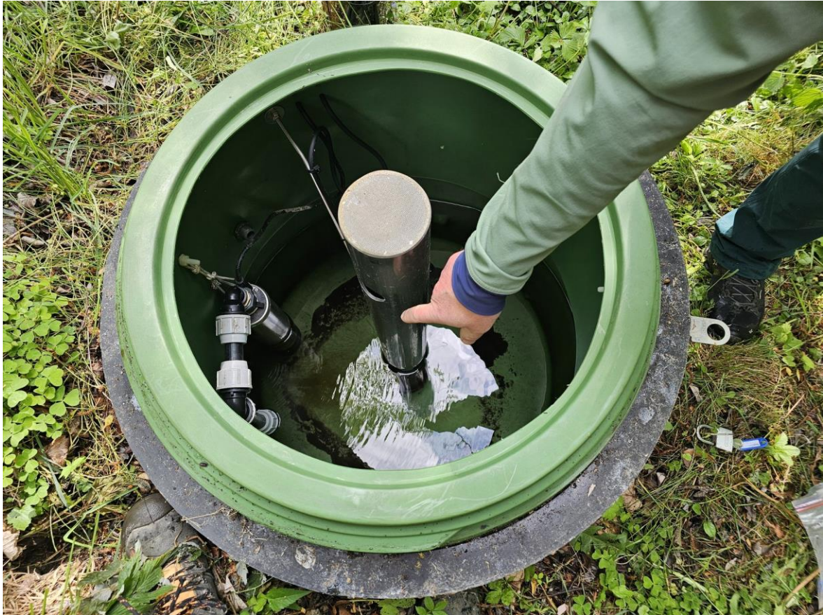
Abb. 3j: Zmöllach 12A – Innenansicht der modernen Quellfassung mit Datenlogger-Rohr, Druckleitung und Magnetventil. Deutlich sichtbar: aktive Wasserführung. Feldaufnahme 31. Mai 2026.
